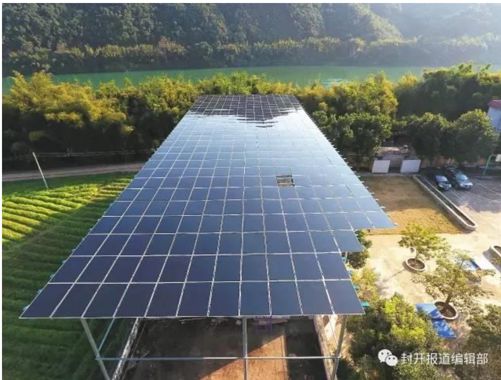
封開縣都平鎮光伏扶貧專案上安裝的漢能銅銦鎵硒薄膜太陽能組件
